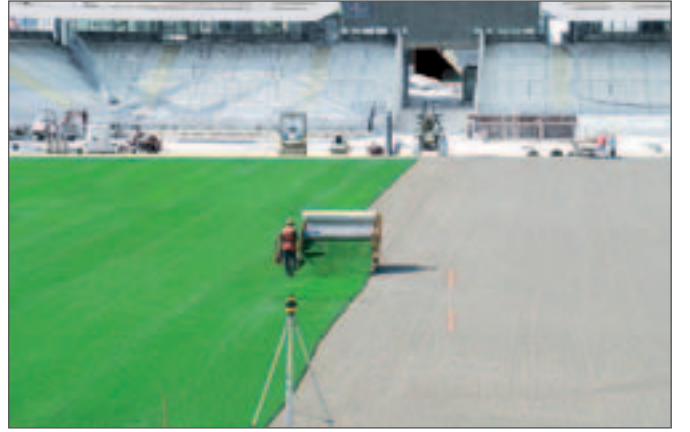
Şekil 9-35 Rulo çimin döşenmesi
