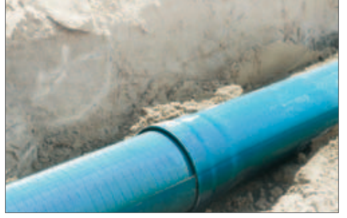
Şekil 9-33 Oyun sahasına drenaj döşenmesi
