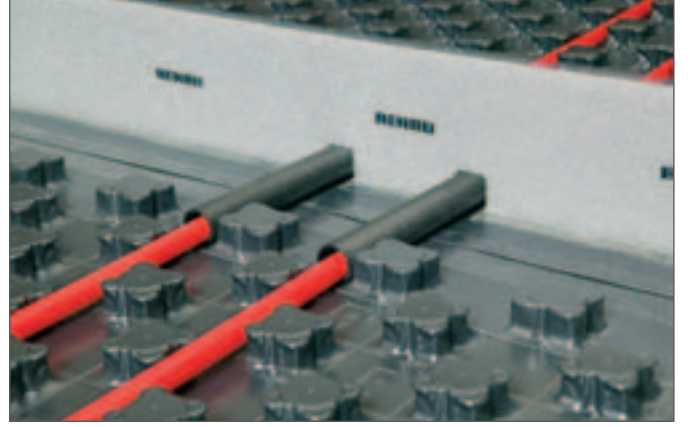
Şekil 5-3 Noppenplatte Varionova üzerinde REHAU genişleme derzi profili
