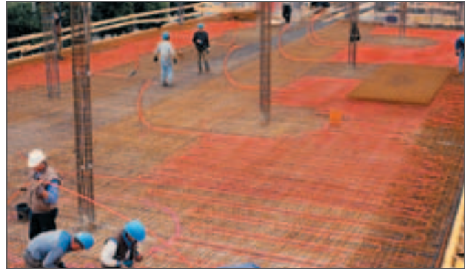
Şekil 8-5 REHAU BKT - şantiyede döşeme
