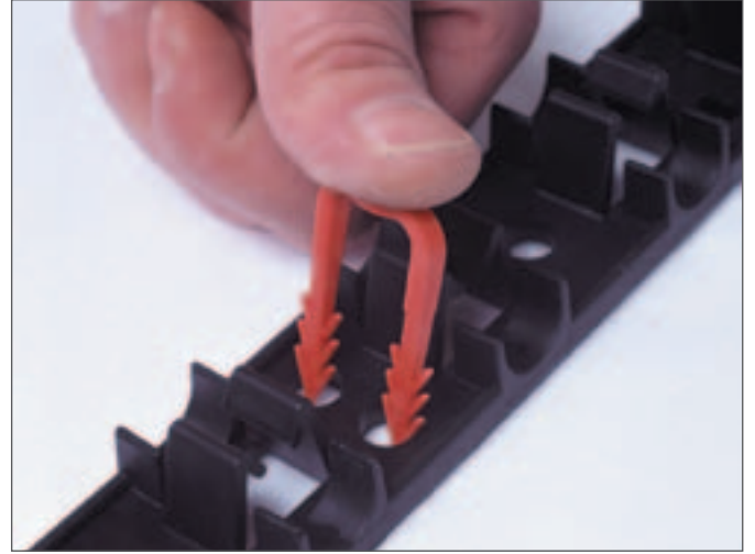
Şekil 3-40 REHAU sabitleyici iğnenin zemin yapısının içine bastırılması
