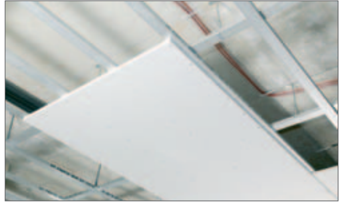
Şekil 4-5 Monte edilmiş tavan plakası
