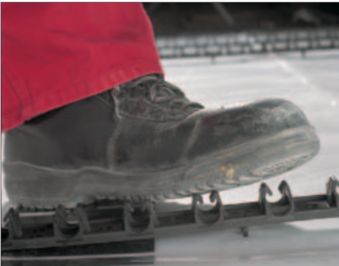
Şekil 3-39 REHAU RAUFIX rayını zemin yapısının içine bastırın
