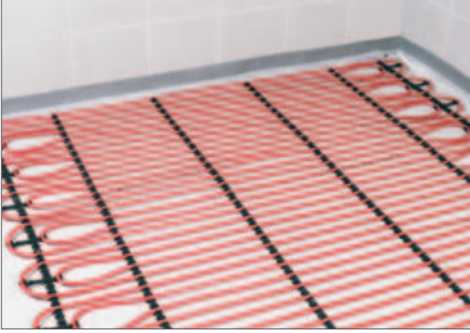
Şekil 3-64 Islak yapı tarzında tutucu ray
