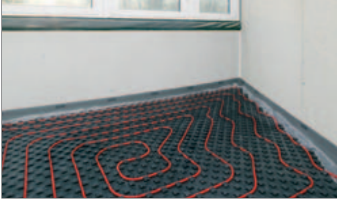
Şekil 3.11 Alt kısmı 30-2 basma sesi yalıtımlı REHAU Noppenplatte Varionova sistemi
