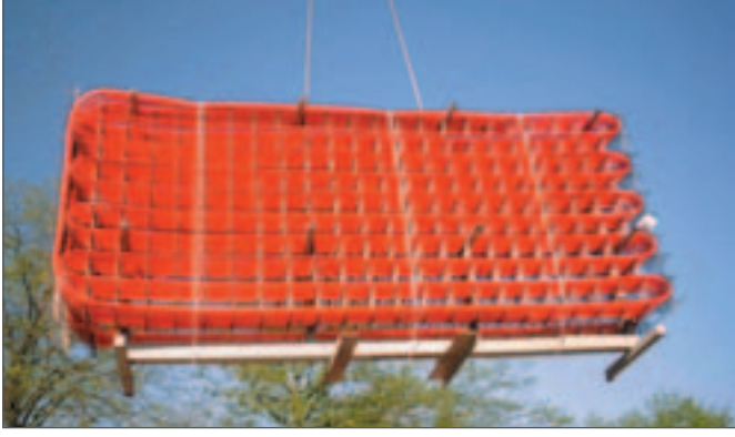
Şekil 8-26 REHAU BKT taşıyıcı gövde
