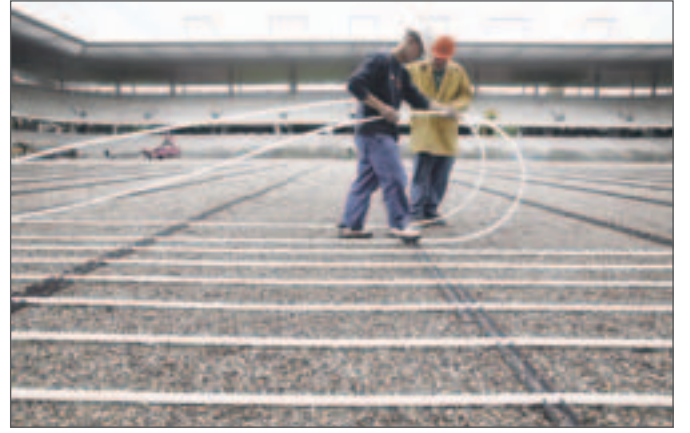
Şekil 9-34 Isıtma borularının döşenmesi
